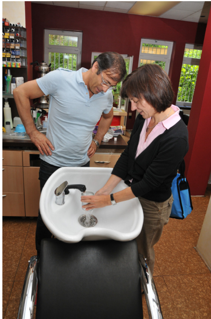
Messung des Wasserdurchflusses. Foto: NordHandwerk
