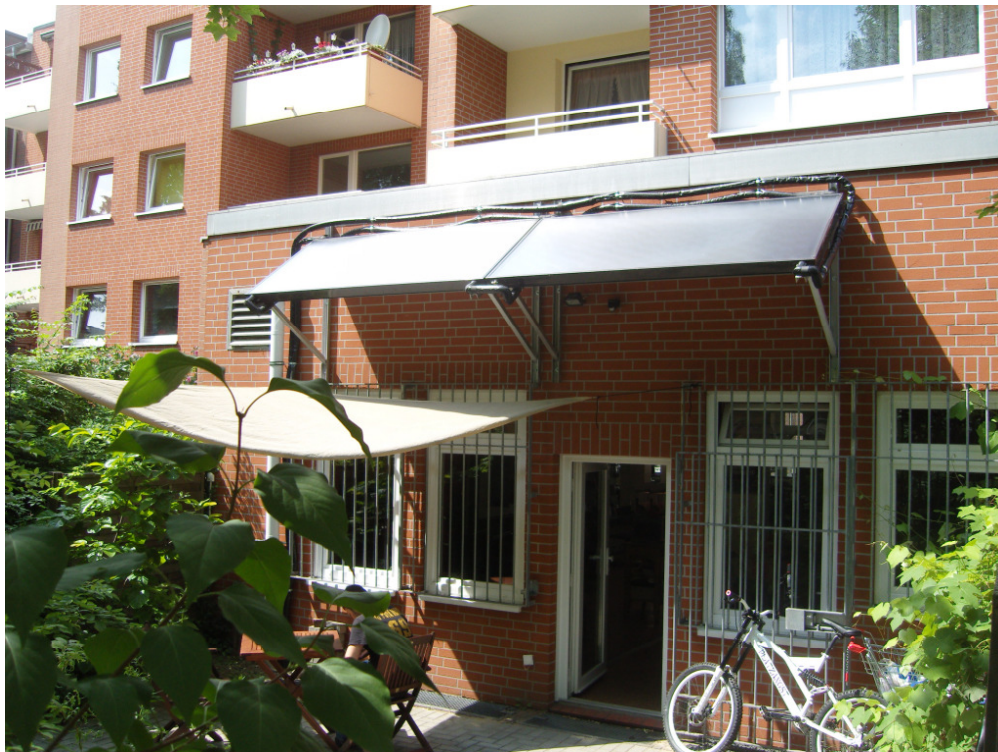
Solkollektoren an der rückwärtigen Fassade. Foto: Salon Görege
